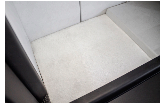
Mata izolacyjna pod wyłożeniem ceramicznym Insulating mat underneath the ceramic lining
